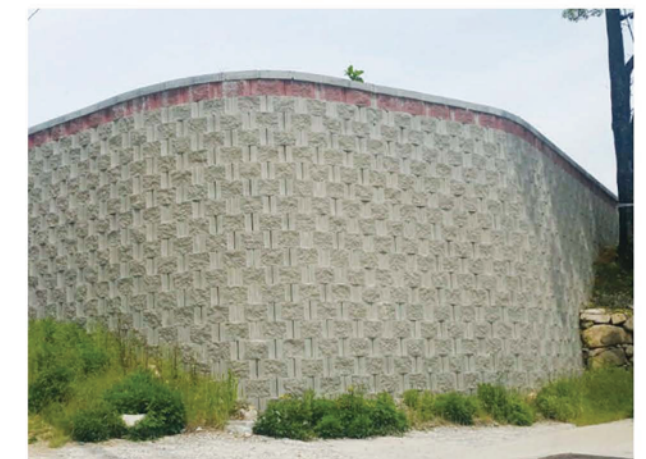
06 캡형 설치 및 마감
